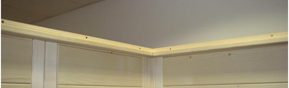
Abb. 17: Einlegen Dachelement hinten mit Lüfterausschnitt
