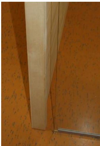
Fig. 12 : Insertion de la vitre dans la rainure du montant d'angle
