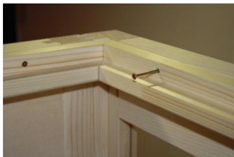
Fig. 15: Montaggio dei listelli di supporto del tetto
