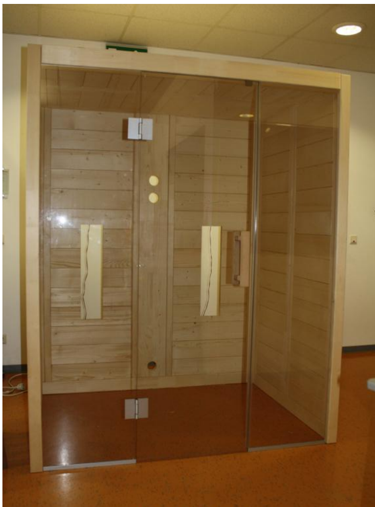
Abb. 26: Fertige Kabinenwände und Dachelemente
