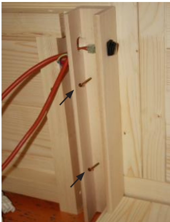
Abb. 32: Montage der U-Leisten für Wärmeplatten
