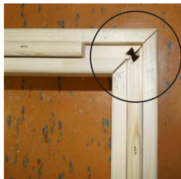
Fig. 2 : Raccorder les éléments du plancher
