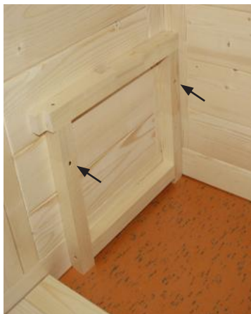
Fig. 31: Montaggio del supporto della panca
