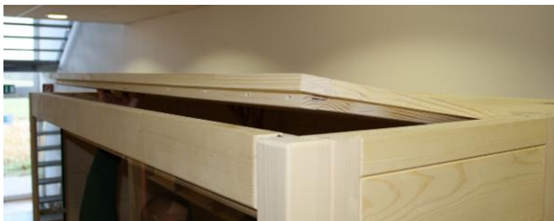
Afb. 18: Plaatsen van dakelementen voorzijde
