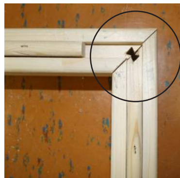
Afb. 2: Bodemelementen verbinden
