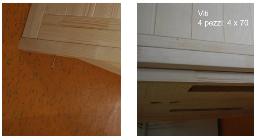
Fig. 47: Montaggio dei listelli distanziatori sul pannello posteriore
