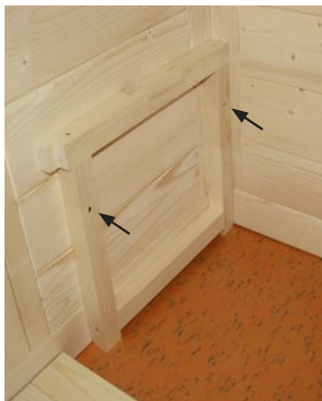
Fig. 31 : Montage du support du banc
