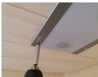
Fig. 45: Montaggio della lampada a colori
