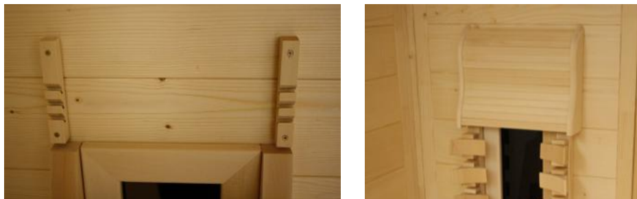
Fig. 48 : Montage des appui-têtes
