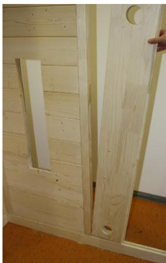
Fig. 6: Inserimento dell'elemento elettrico
