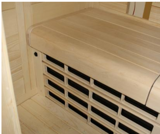
Fig. 36 : Pose du banc
