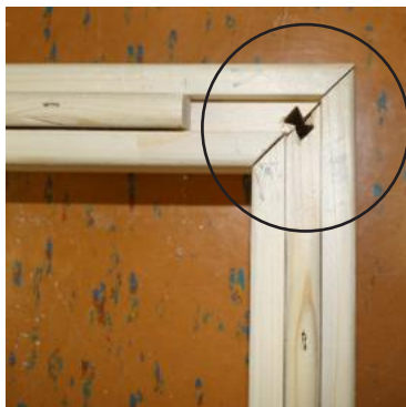
Abb. 2: Bodenelemente verbinden
