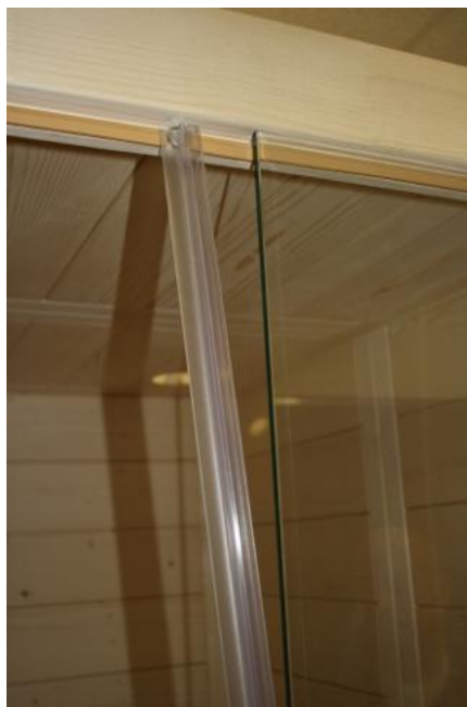
EN Fig. 19: Installing the door insulation strips
