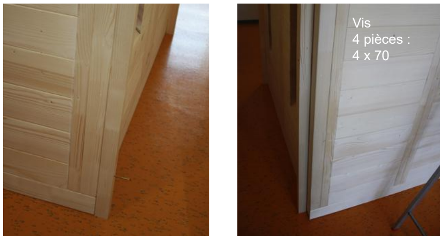
Fig. 47 : Montage des barres d'écartement paroi arrière
