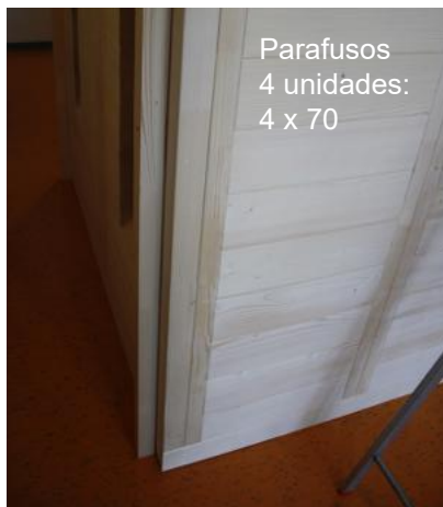
Fig. 48: Montagem das barras distanciadoras na parede traseira
