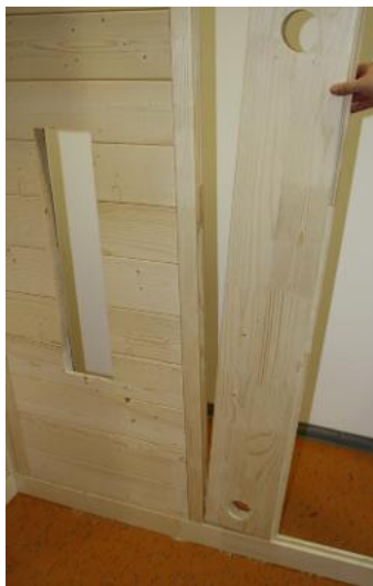
Fig. 6 : Insérer l'élément électrique
