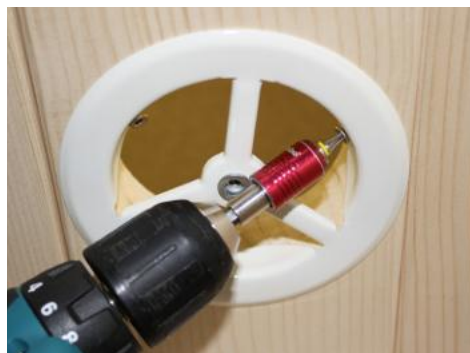
Fig. 36: Montagem da ventilação
