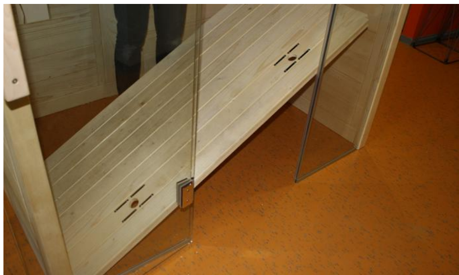
Fig. 27: Inserimento del pavimento della cabina
