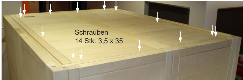
Abb. 19: Befestigen der Dachelemente
