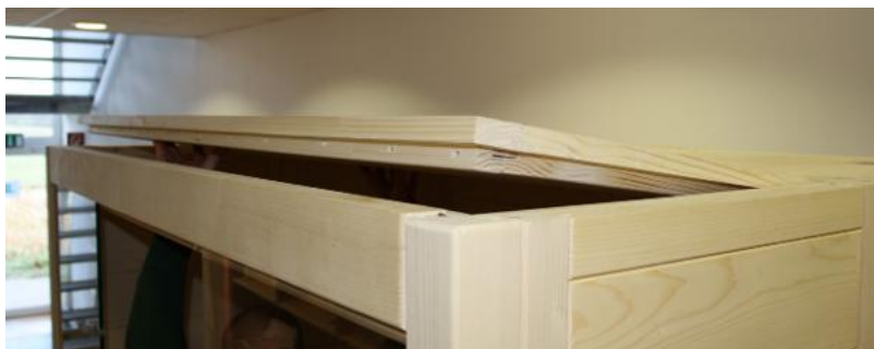
Fig. 18 : Insertion de l'élément de toit avant
