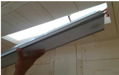
Abb. 45: Montage Farblampe
