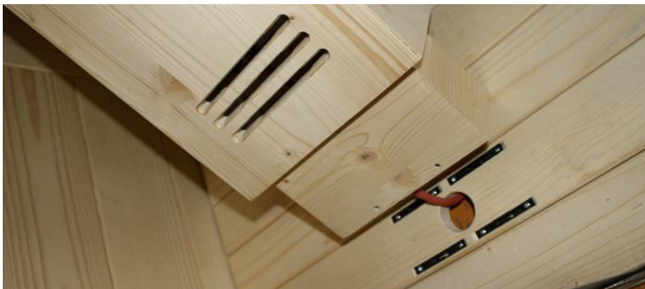
Fig. 29: Fixar o radiador frontal
