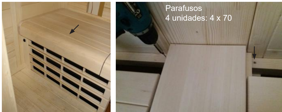
Fig. 47: Fixação do banco
