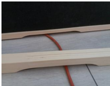
Fig. 35: Instalação da barra de reforço para placas de aquecimento por IV VitaMy
