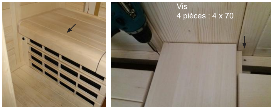
Fig. 46 : Fixation du banc
