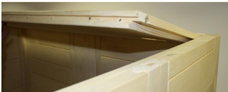
Fig. 18: Inserção dos elementos de teto da frente
