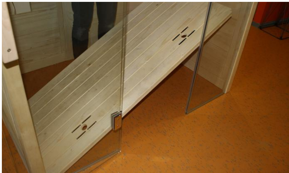
Fig. 28: Inserir o chão da cabina
