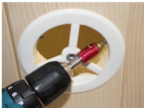
Fig. 35 : Montage de la ventilation
