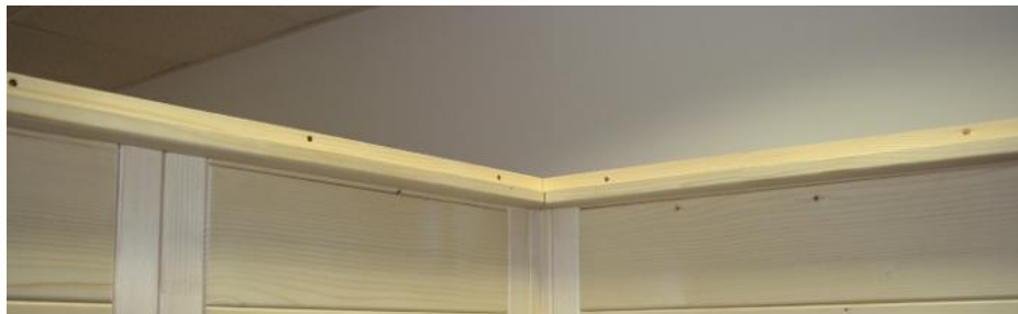
Afb. 17: Plaatsen van dakelement achter met ventilatoruitsparing
