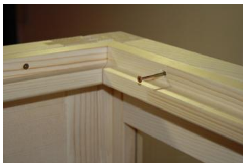
Fig. 15 : Montage baguettes d'appui de toit
