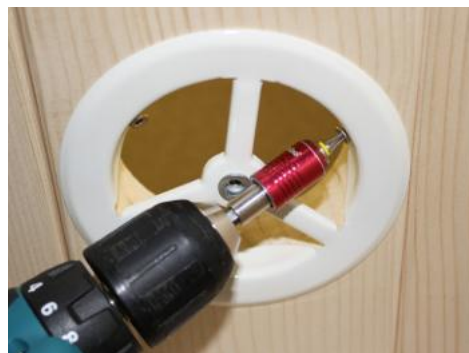
Fig. 35: Montaggio della ventilazione
