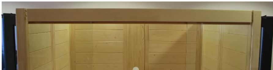
Fig. 15: Fixação da barra maciça
