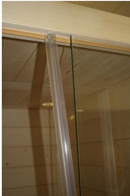
Abb. 20: Aufsetzen der Türdichtung
