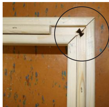
Fig. 2: Collegamento degli elementi del pavimento
