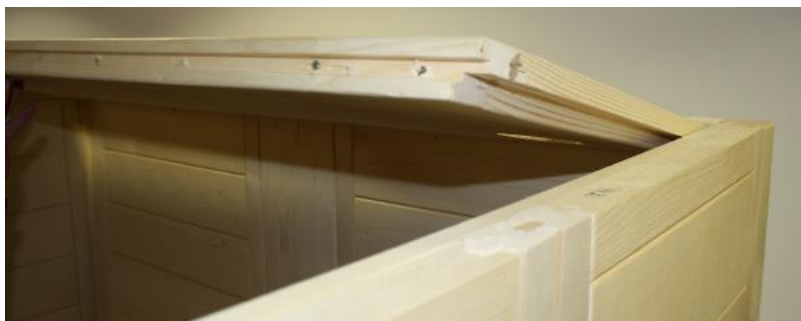
Fig. 18 : Insertion de l'élément de toit avant
