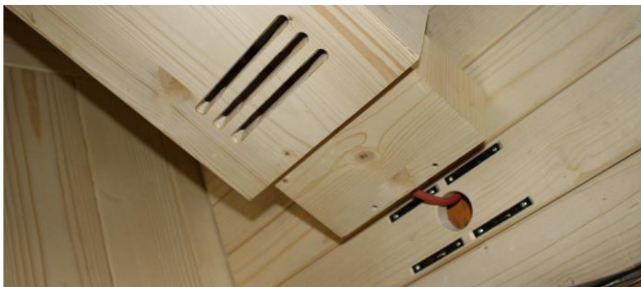
Fig. 28: Fissaggio degli irradiatori anteriori
