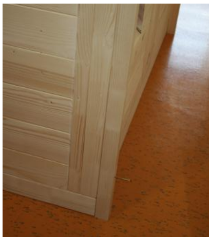
Abb. 47: Montage Abstandleisten Rückwand
