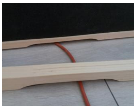
Fig. 34: Inserimento del listello di rinforzo per pannelli radianti IR VitaMy
