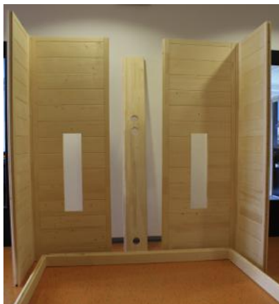
Fig. 5: Montagem na armação do chão
