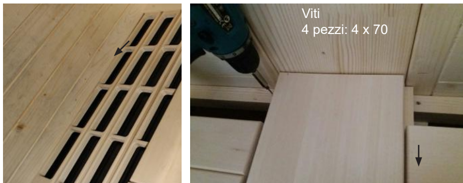
Fig. 46: Fissaggio della panca
