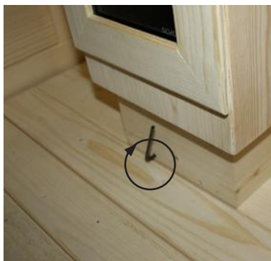
Fig. 30 : Insertion des coupelles en pierre ollaire
