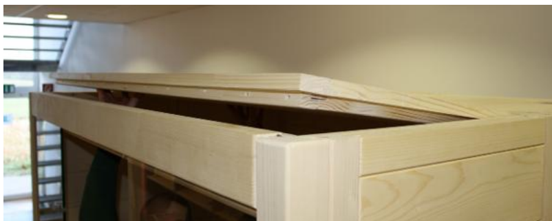
Fig. 18: Inserimento dell'elemento tetto anteriore
