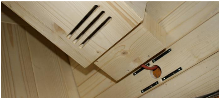
Fig. 28 : Fixer le radiateur avant
