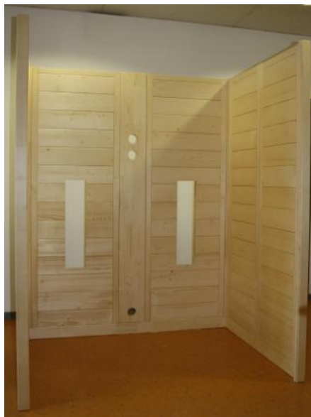
Fig. 10: Elementos de parede montados
