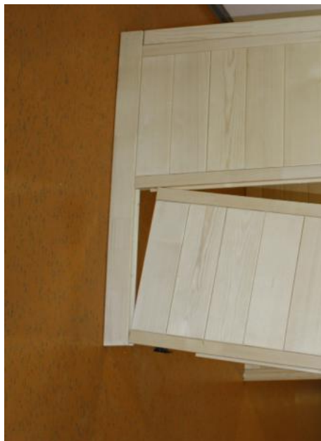
Fig. 10: Elementi parete montati
