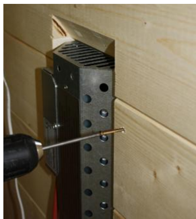
PT Fig. 39: Montar o painel dos radiadores traseiros
