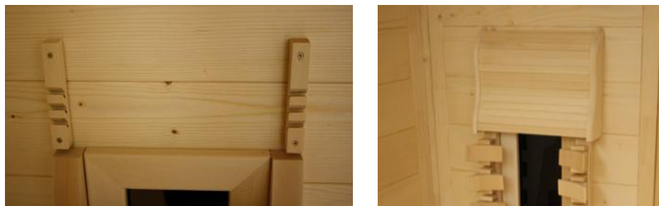
Fig. 49: Montagem dos apoios de cabeça
